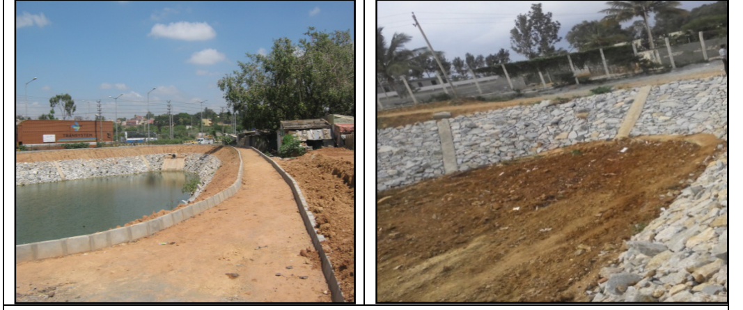
ಸಾಸರ್ ಆಕೃತಿಯ ಹೂಳೆತ್ತಿರುವುದನ್ನು ಬಿ.ನಾರಾಯಣಪುರ ಕೆರೆಯಲ್ಲಿ ಮತ್ತು ಉಂಗುರಾಕಾರದ ಏರಿಯನ್ನು ನಿರ್ಮಿಸಿರುವುದನ್ನು ಚೊಕ್ಕನಹಳ್ಳಿ ಕೆರೆಯಲ್ಲಿ ಗಮನಿಸಲಾಯಿತು
